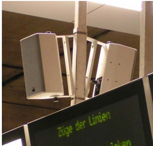
Speziell angefertigte Lautsprecherhalterung zur geneigten Montage
