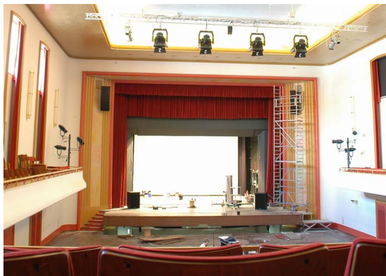
Saalansicht vom Balkon aus - "in der Bauphase"
