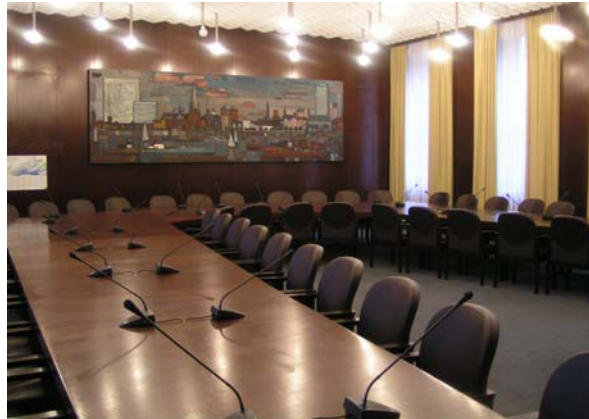
Aufgebaute Diskussionsanlage im Sitzungssaal
